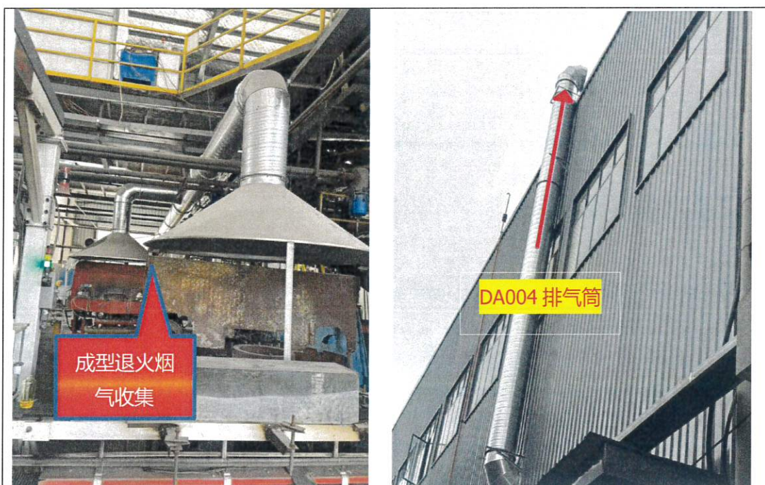
图 3-4 成型退火烟气 DA004 现场照片
