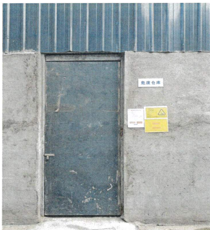
图 3-5 危废暂存间照片
